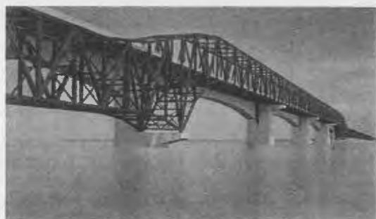
図-2 鋼トラス橋による架け替え完成イメージ (出典：経済産業省)
