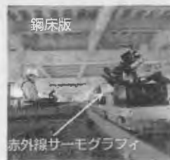
図-7 赤外線サーモグラフィによる疲労き裂点検
