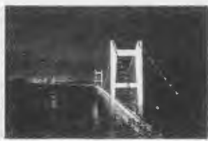
写真-11 瀬戸大橋ライトアップ
