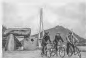
写真-9 多々羅大橋とサイクリスト
