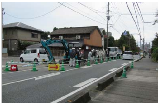
施工箇所全景
