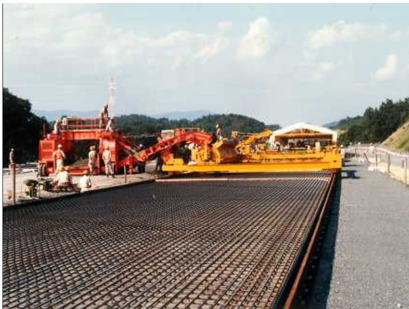
常磐自動車道における連続鉄筋コンクリート舗装の施工
