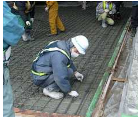
端部補強筋の設置
