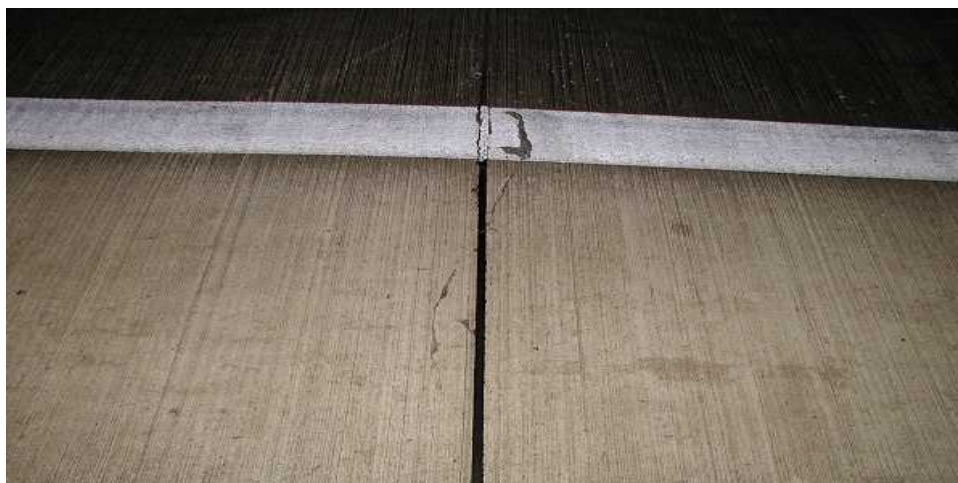
ダウエルバー（ジョイントアッセンブリ）の設置の不適切によると見られる目地部のひび割れ （前後2枚の版にまたがってS字状に生じている） これから角欠けに進展していく
