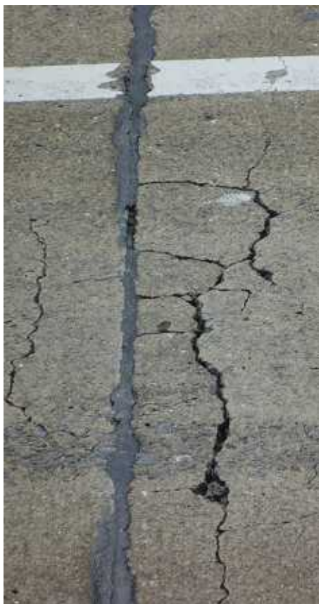
ダウエルバー（ジョイントアッセンブリ）の設置の不適切によると見られる目地部のひび割れ （前後2枚の版にまたがってS字状に生じている） これから角欠けに進展していく
