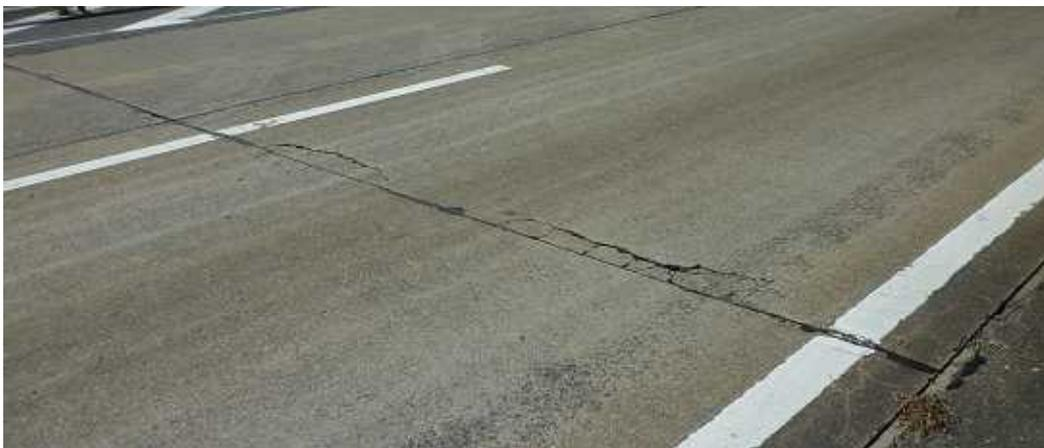
例えば、上の写真の目地部2箇所ひび割れは、観察によるといずれも目地金物部のみに
