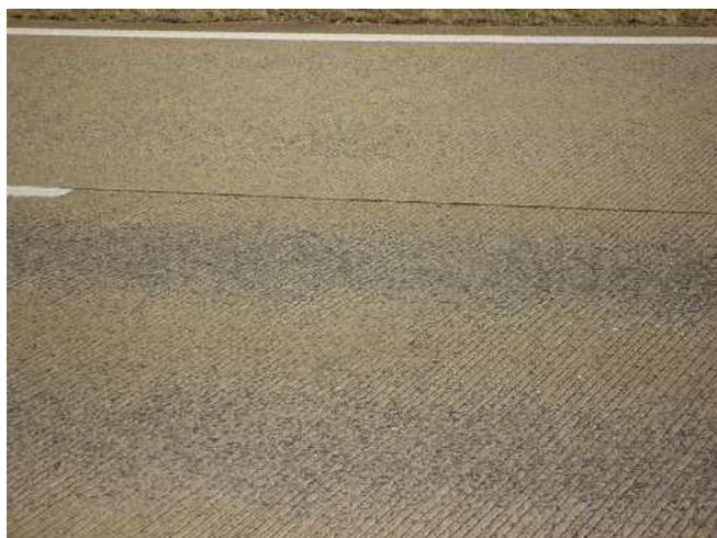
この工法は、高速道路で先行して施工されたコンクリート舗装（東北自動車道 矢板～白川間 他）が摩耗により徐々に滑りやすい路面になったことから始まった対策で、九州横断自動車道（佐賀県内）等に施工されている。
